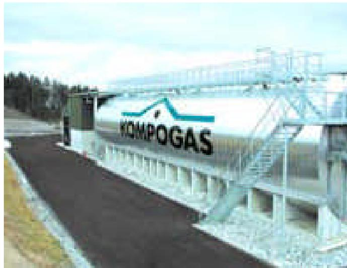
*Bild 11: Ppropfenstrom -Fermenter*
